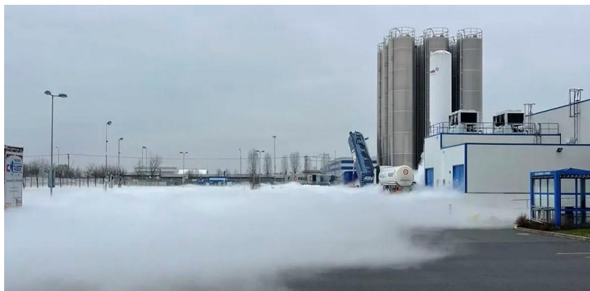
Obr. 1 Situace na místě zásahu během úniku CO 2 [3]
