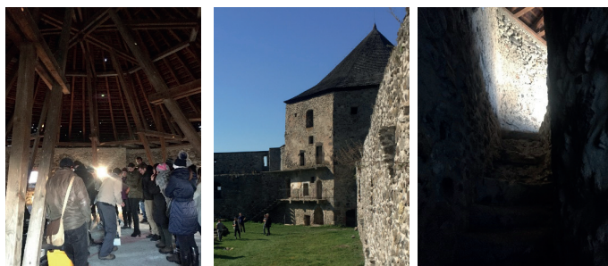
Obr. 6 Obrázky zo vstupnej veže, kde predpokladáme vznik požiaru od elektroinštalácie
